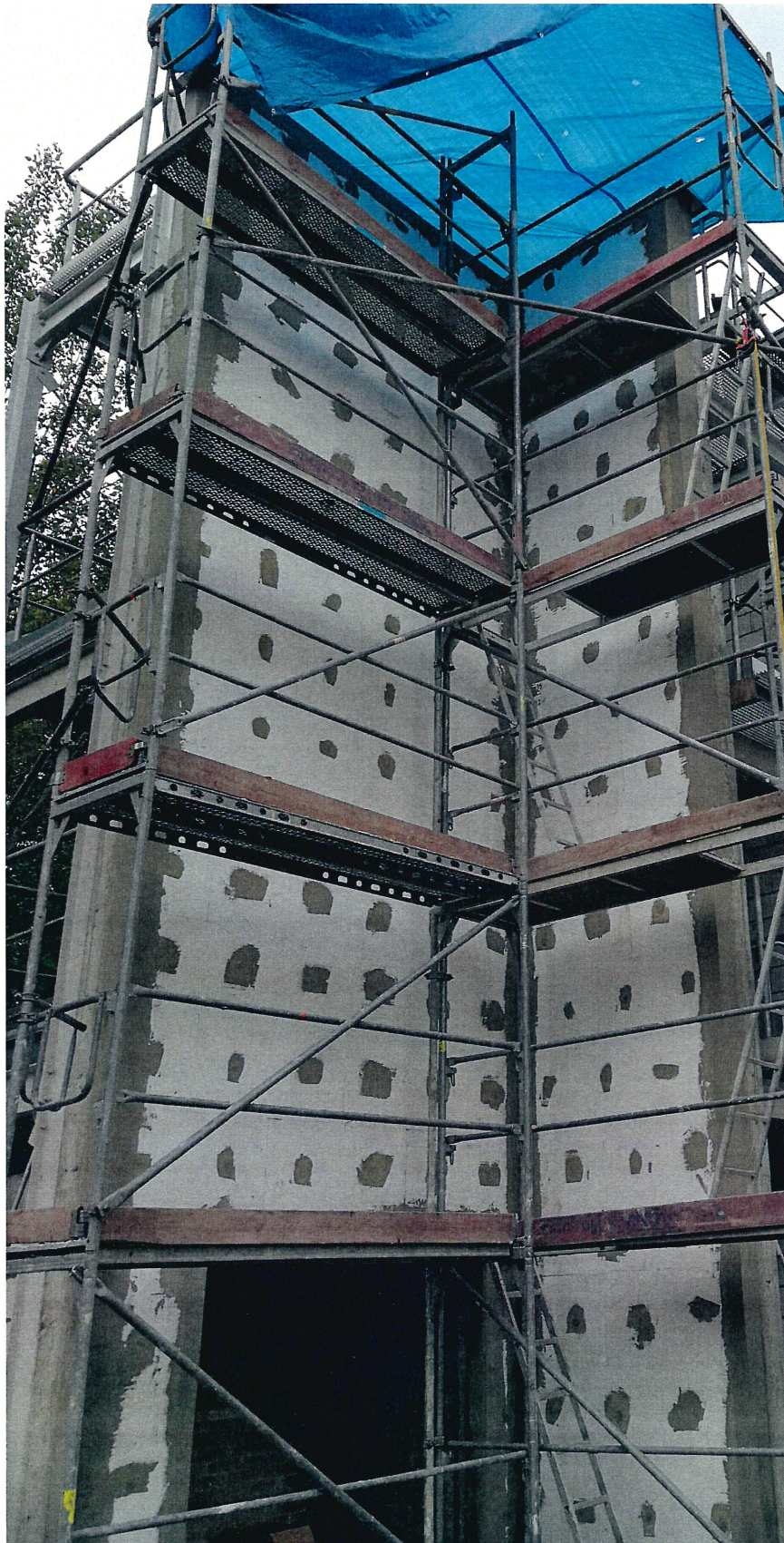
Fotografia 4. Przygotowanie systemu do badań
