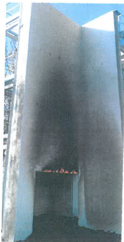
Fotografia 35. System w trakcie badania – po wygaszeniu źródła ognia
