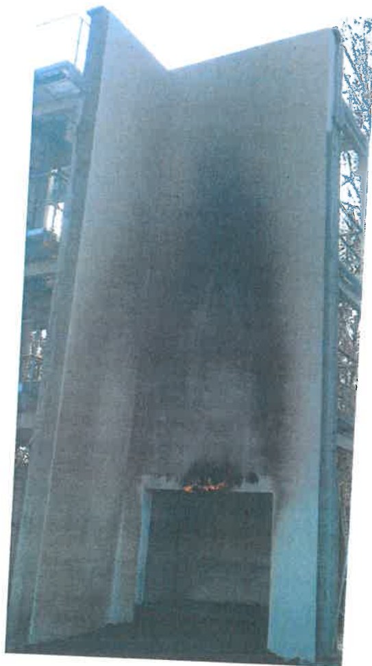
Fotografia 40. System po wygaszeniu źródła ognia
